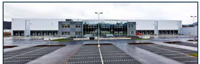
Nach vielen Jahren mit Telefonaten, Meetings, Planungs- und Bauphasen konnte das Parts Europe Lager im Jahr 2009 eröffnet werden. Die Größe des Geländes betrug etwa 20.000 m 2 .
